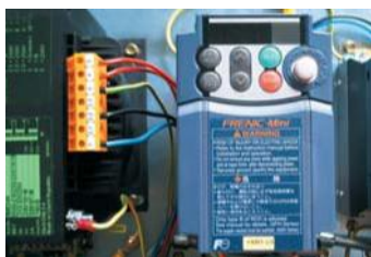
8 Плавный пуск, остановка и изменяемая скорость движения, благодаря частотнорегулируемым приводам.
